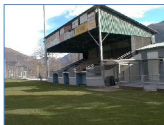
La tribune du stade qui est souvent qualifiée « d'abribus » par les médias
